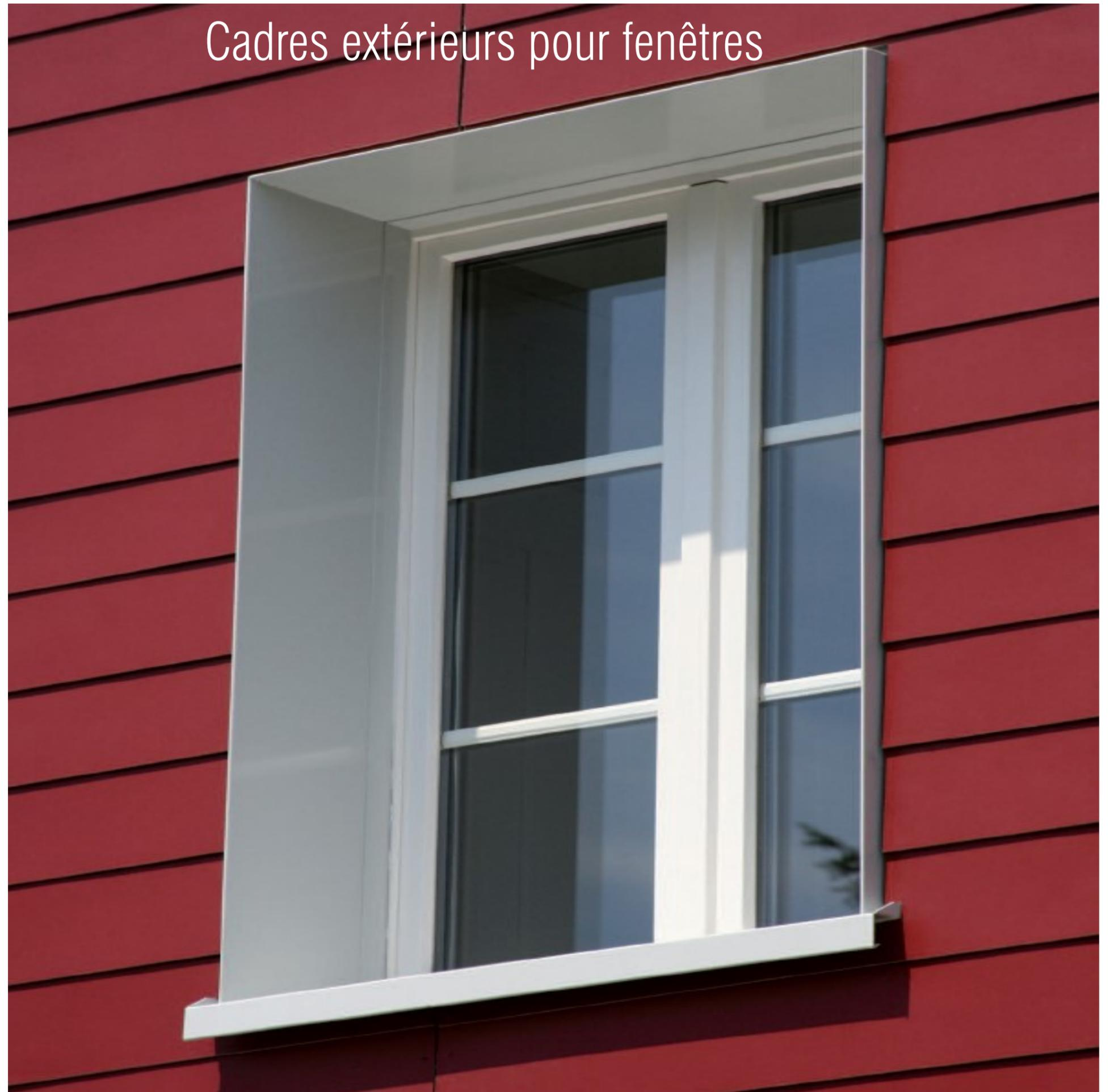
Les cadres extérieurs Alpro - la solution idéale pour la finition des murs latéraux des fenêtres et façades isolées ou des façades ventilées.
